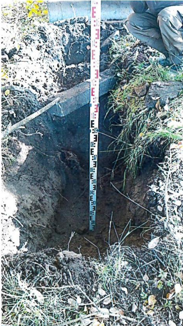
Abbildung 9: Schurf 2 mit einem der beiden angetroffenen Betonstürze am 27.10.2015
