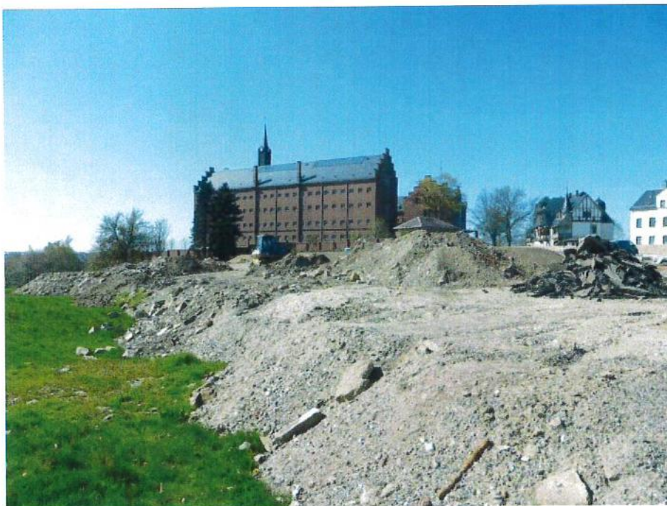
Foto 20: Ostteil des UG im Übergang zur Baufläche des Besucherparkplatzes Schloss Aufnahme vom 21.04.2016
