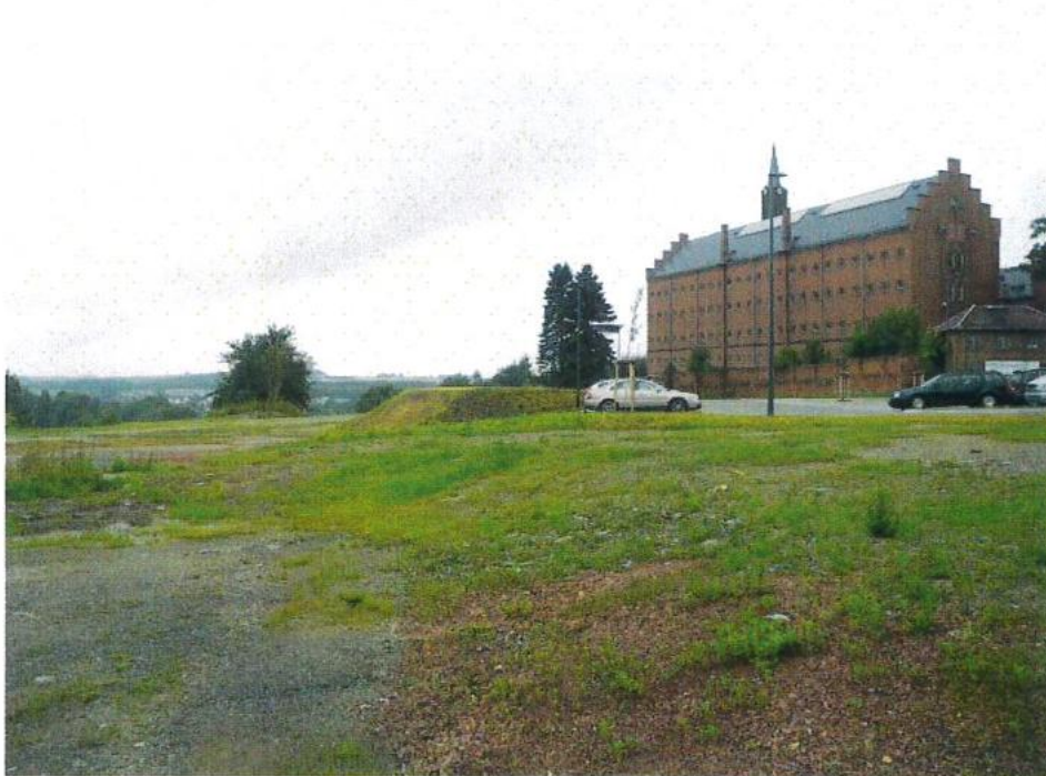
Foto 22: Fertiggestellter Besucherparkplatz und beräumter Bauplatz
