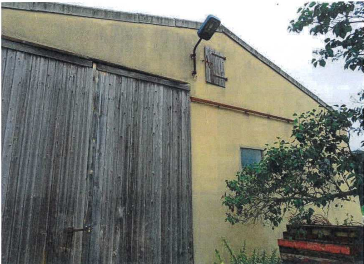
Foto 6: Detailansicht Lagerhalle (Südseite) mit Spalten/Nischen im Dachbereich als potenzielles Sommer-/Zwischenquartier gebäudebegleitender Fledermausarten, 14.08.2020.
