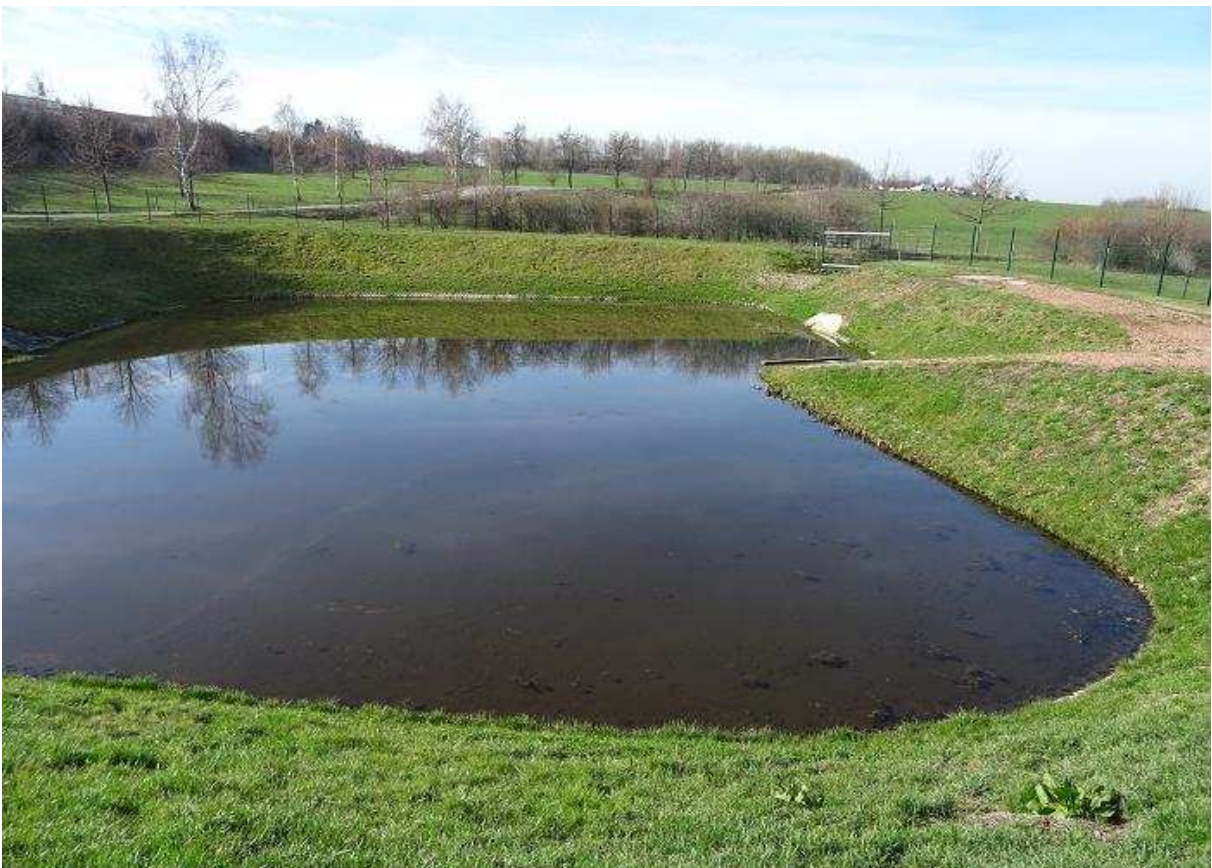
Foto 8: Abwassertechnische Anlage der WAD im Osten des strukturierten zentralen Grünstreifens, 22.03.2019.
