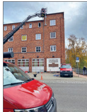
Sirenenerrichtung am Gerätehaus der FFW Stollberg
